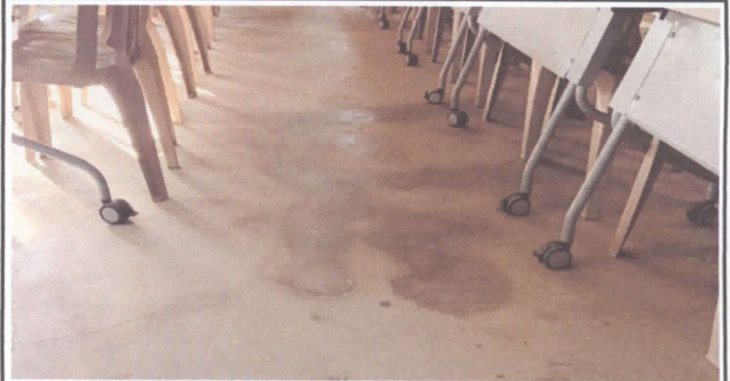
Foto 2: Sustitución de piso de torta de concreto a piso cerámico
