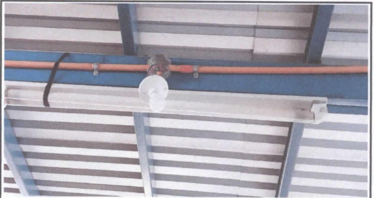
Foto 4: Sustitución de lamparas tipo Led
