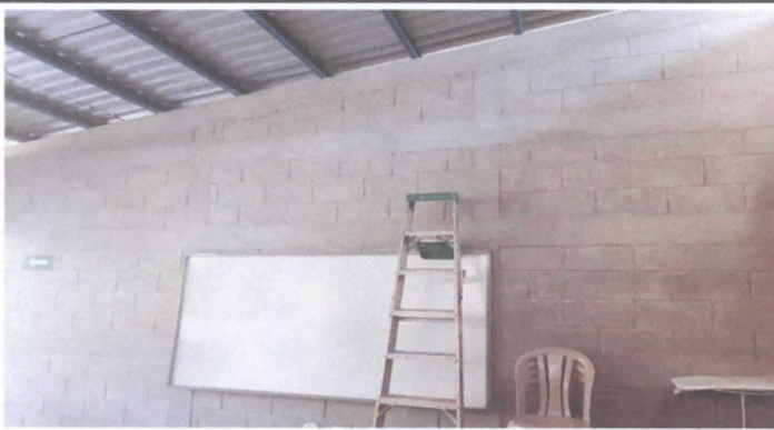
Foto 3: Pintura en muros exteriores e interiores
