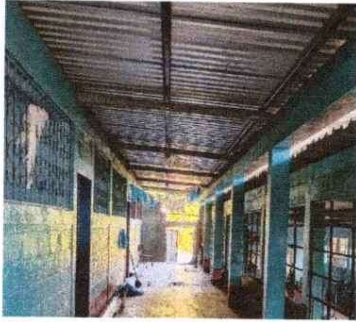
Foto 1: Sustitución de lámina
