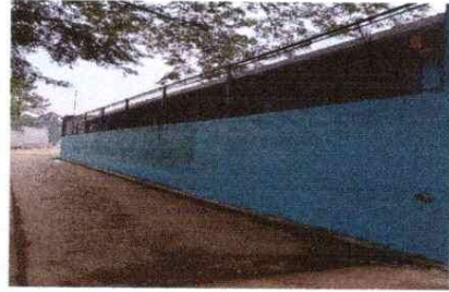
Foto 2: Pinturas en muros exteriores e interiores
