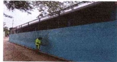
Foto 2: Pinturas en muros exteriores e interiores
