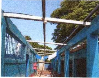
Foto 1: Sustrucción de lámina
