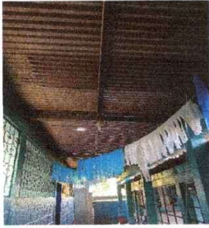
Foto 1: Sustitución de lámina
