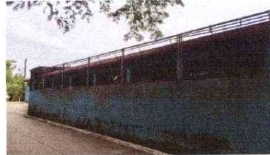
Foto 2: Pinturas en muros exteriores e interiores
