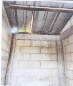
Foto 5: Sustrucion de lamina por lamina troquelada y soporte de estructura de madera por metal.
