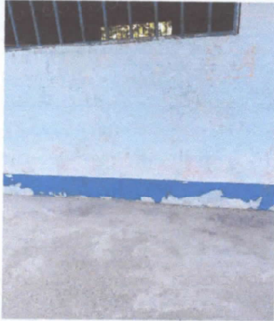
Foto 7: Pintura en muros exteriores e interiores.
