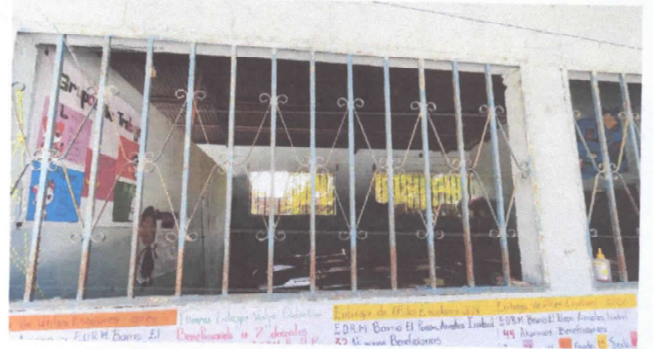
Foto 4: Sustruciones de Balcones de metal.
