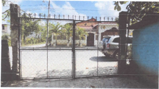
Foto 1: Sustrucion de porton de metal.
