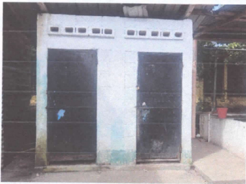
Foto 3: Sustrucion de puertas de servicio de sanitarios.
