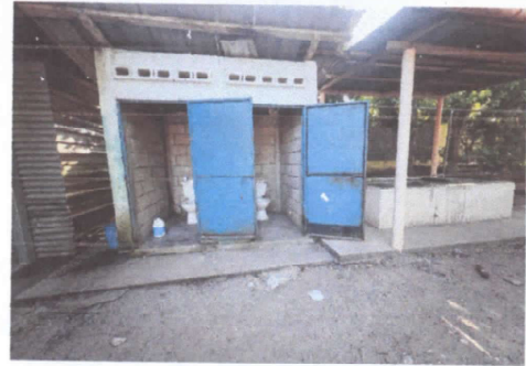
Foto 8: Sustitucion de Inodoros
