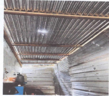
Foto 2: Sustrucion de lamina por lamina troquelada.
