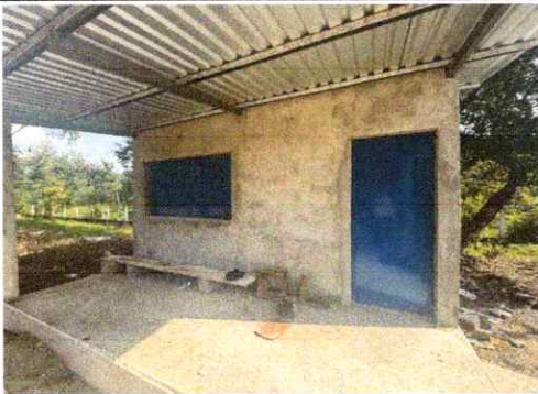
Foto 5: REPELLO EN MUROS
