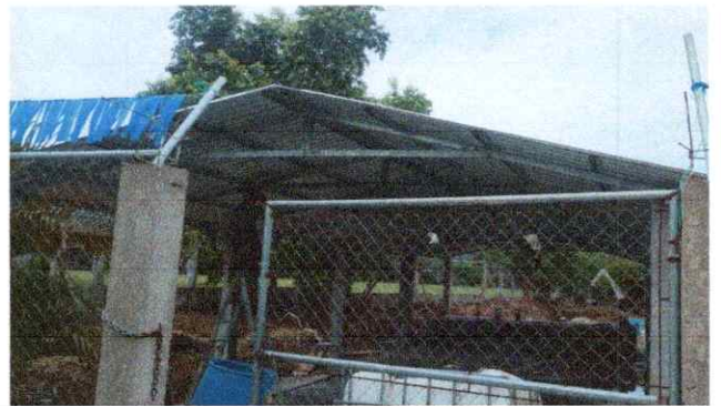
Foto 2: SUSTITUCION DE ESTRUCTURA DE SOPORTE DE MADERA POR METAL
