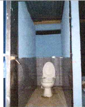
Foto 4: SUSTITUCION DE SANITARIOS E INSTALACION DE AZULEJO
