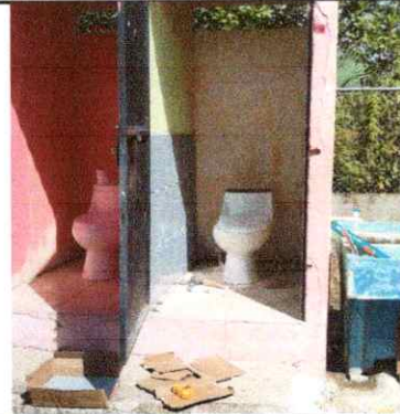
Foto 4: SUSTITUCION DE SANITARIOS E INSTALACION DE AZULEJO
