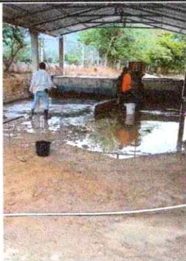
Foto 3: REPARACION DE TORTA DE CEMENTO
