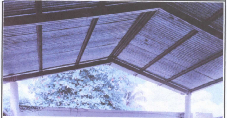
2.1 Sustitución soporte metal por metal
