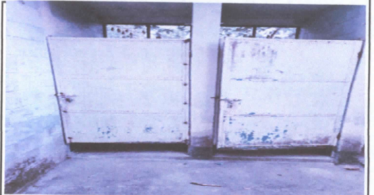
5.1 Sustitucion puerta de metal
