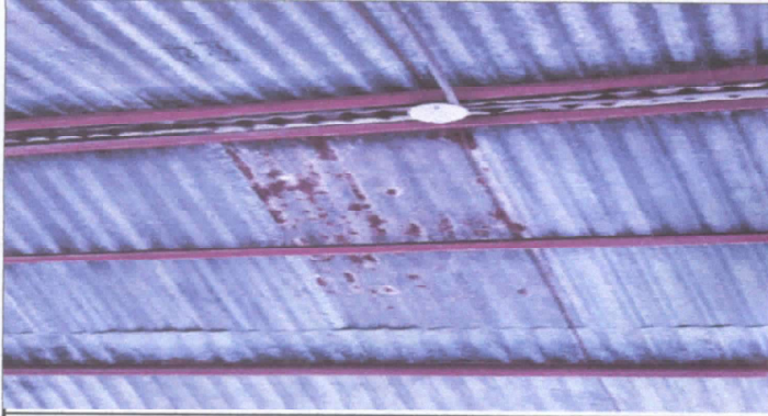
1.1 Sustitución de lámina, por lámina troquelada aluzinc 26
