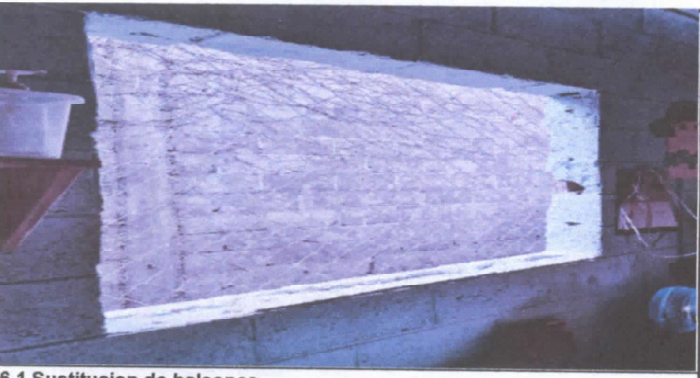
6.1 Sustitución de balcones
