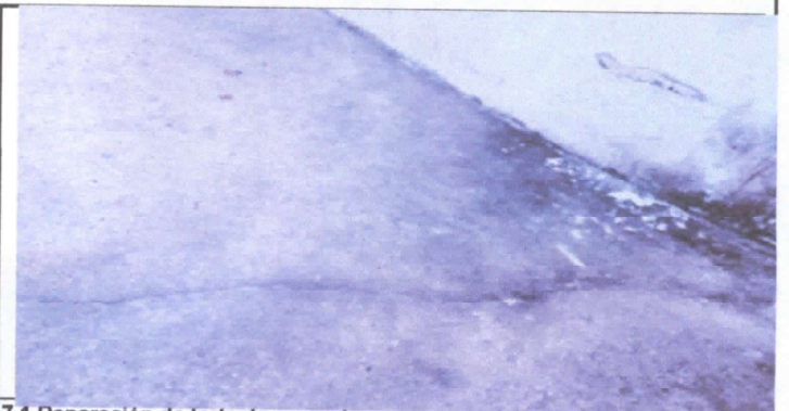
7.1 Reparación de torta de cemento
