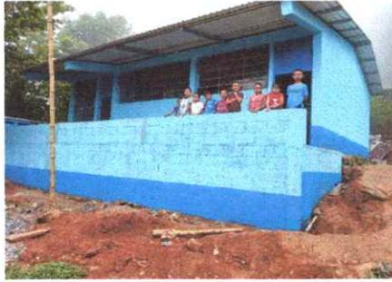
Foto1: SUSTITUCION DE MURURO DE CONTENCIÓN
