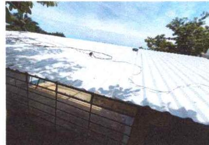
Foto 4: SUSTITUCION DE ESTRUCTURA METALICA Y CUBIERTA DE LAMINA EN SALON DE CLASES
