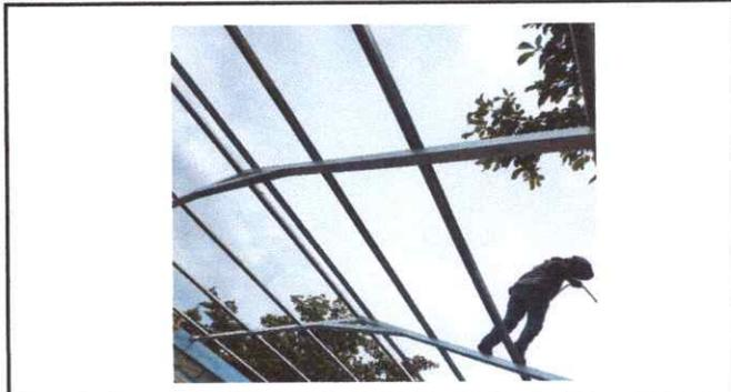
Foto 2: SUSTITUCION DE ESTRUCTURA METALICA Y CUBIERTA DE LAMINA EN BAÑOS
