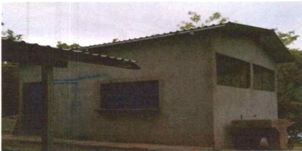
reparación de pared en cocina terminado
