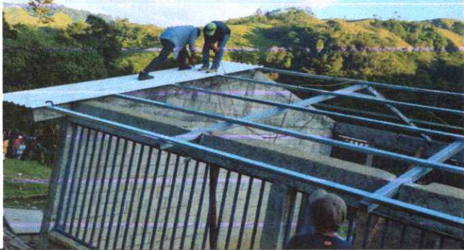
CUBIERTA DE LAMINA
