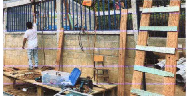
SUSTITUCION DE VENTANAS DE MADERA POR BALCONES DE METAL
