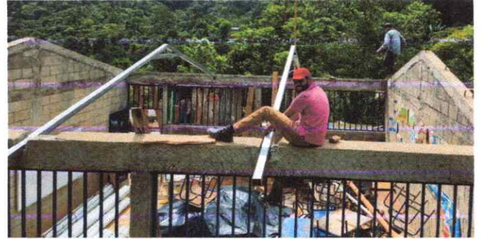
ESTRUCTURA DE TECHO
