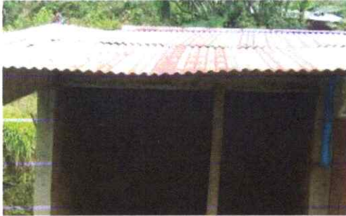
CUBIERTA DE LAMINA
