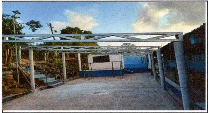
2. Sustitución de estructura de madera por metal.
