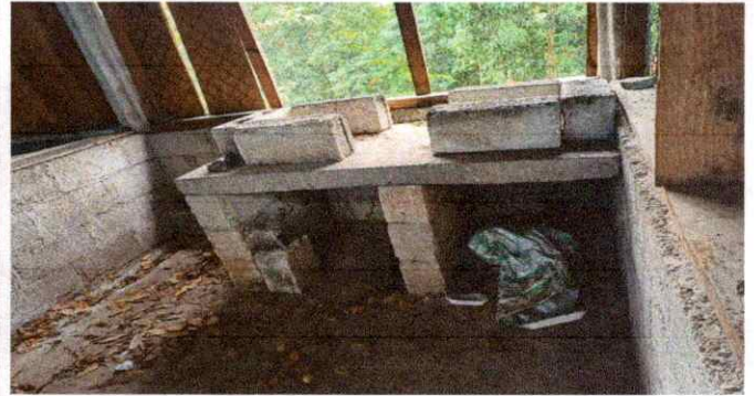
20.2 Sustitución de estufa rural (completa) incluye chimenea y plancha de metal
