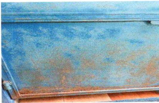
4.3 Sustitución de puerta
