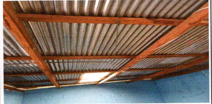
2.2 Sustitución de estructura de madera por metal
