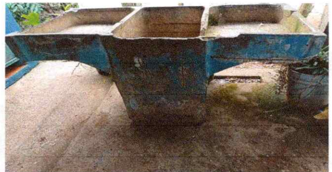
20.10 Sustitución de pila de cemento de dos lavadero
