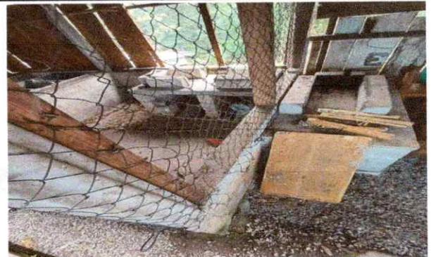
5.2 Sustitución de estructura de metal de ventana
