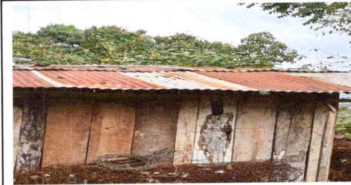
1.1 Sustitución de lámina, por lámina troqueladaaluzinc calibre 26
