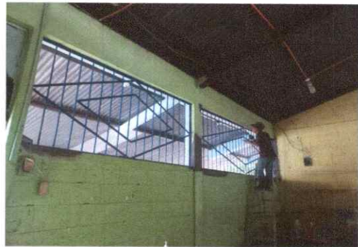
Foto 4: Proceso de inducción de sistema eléctrico en ducto
