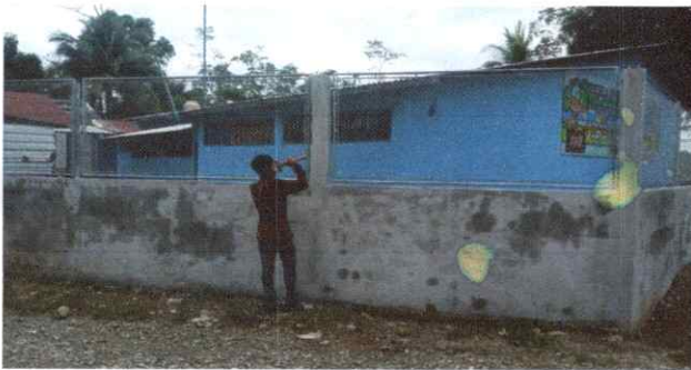
Foto 3: Instalación de bloques de maya en muro perimetral
