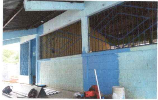
Foto 2: aplicación de primera lámina de pintura en paredes exteriores
