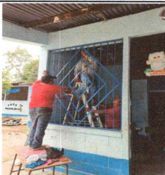
Foto 5: Instalación de balcones de hierro
