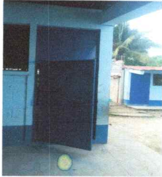
Foto 1: Puerta del aula de cuarto grado en proceso de secado de pintura
