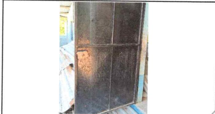
Foto 1: Puerta de cada una de las aulas corroidas o rayadas
