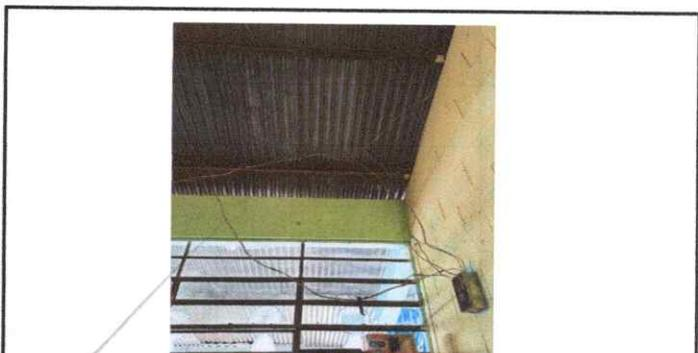
Foto 4: sistema eléctrico sobrepuesto y en mal estado en cada una de las aulas
