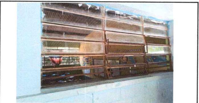
Foto 5: ventanas abatibles y balcones ineficientes del aula de cuarto grado
