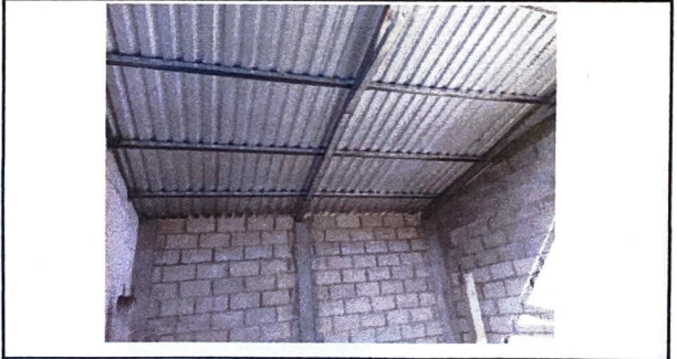
Foto 3: INSTALACION DE LAMINA
