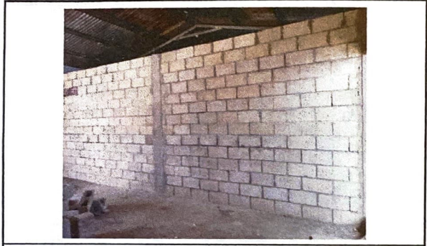
Foto 1: REMOZAMIENTO DE MURO DEVISOR EN AULAS
