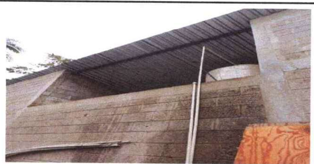
Foto 5: SUSTITUCIÓN DE AGUA 110 LT
