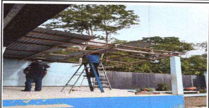
Foto 2: Reparación de estructura.
