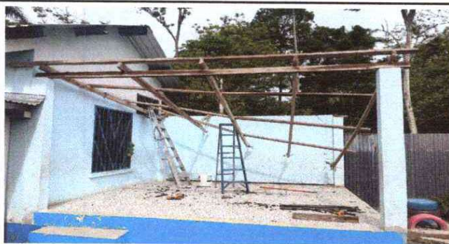
Foto 3: Sustitución de estructura de madera.
