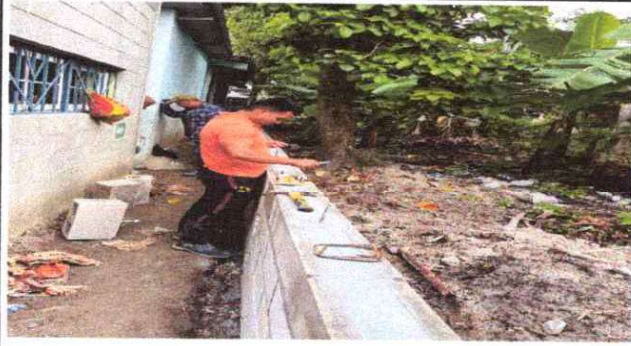
Foto1: Sustitución de muro perimetral.
