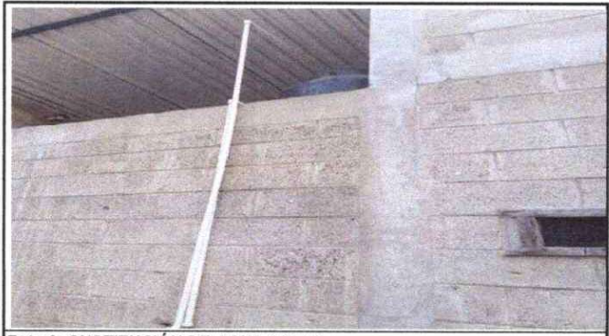
Foto 3: SUSTITUCIÓN DE AGUA 110 LT
