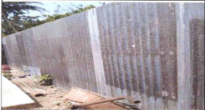
Foto1: REPARACIÓN DE MURO PERIMETRAL DE BLOCK CON TUBO HG Y MALLA GALVANIZADA SOLERAS Y COLUMNAS
