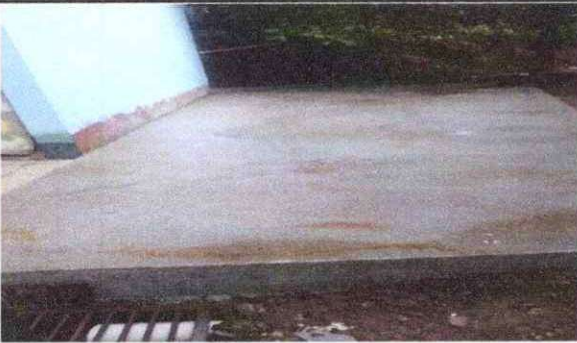
Foto 3: elaboracion de losa de patio
