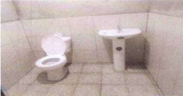
Foto 1: instalación de baño en el aula de parvulos
