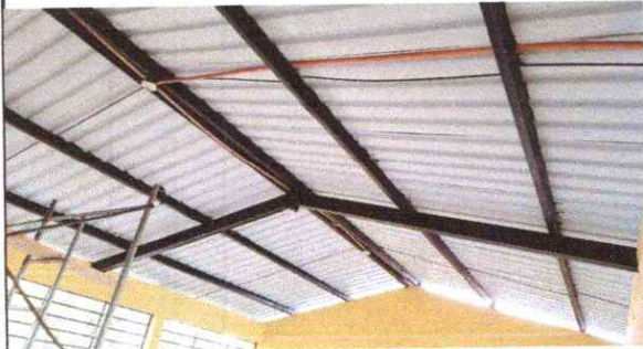
Foto 3: MANTENIMIENTO DE ESTRUCTURA DE METAL
