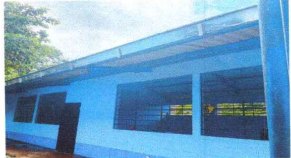
Foto 2: PINTADO DEL AULA DE PARVULOS Y COLOCACION DE CANALES
