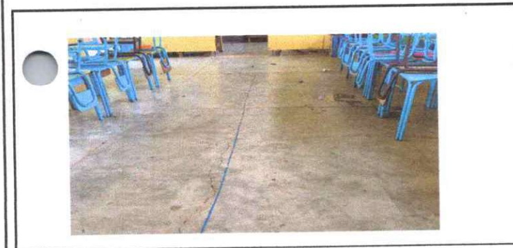
Foto 5: Sustitucion de piso por granito
