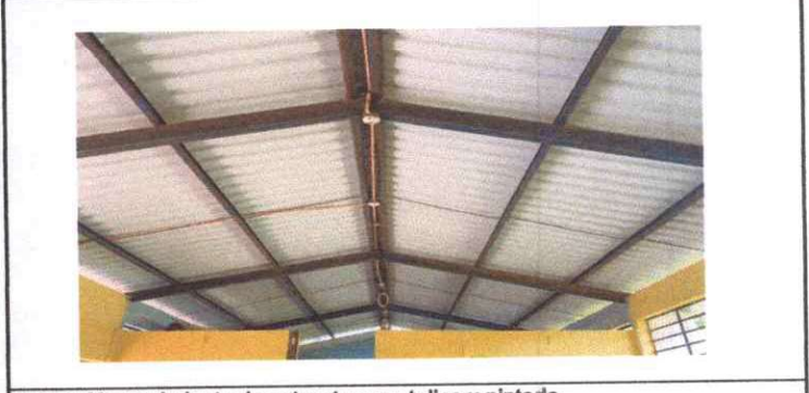
Foto 2: Mantenimiento de estructura metalica y pintado
