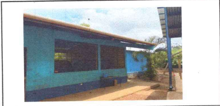
Foto 1: mantenimiento de canales de metal
