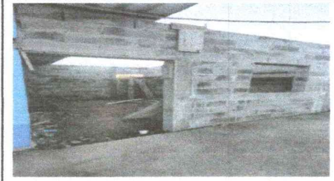
Foto 2: CAMBIO DE TECHO DE BODEGA
