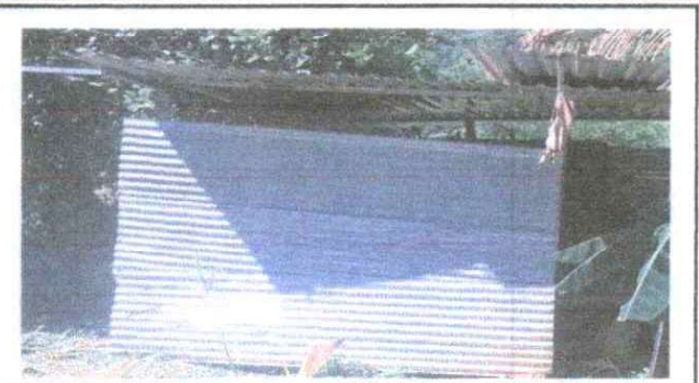
Foto 2: CAMBIO DE TECHO DE BODEGA
