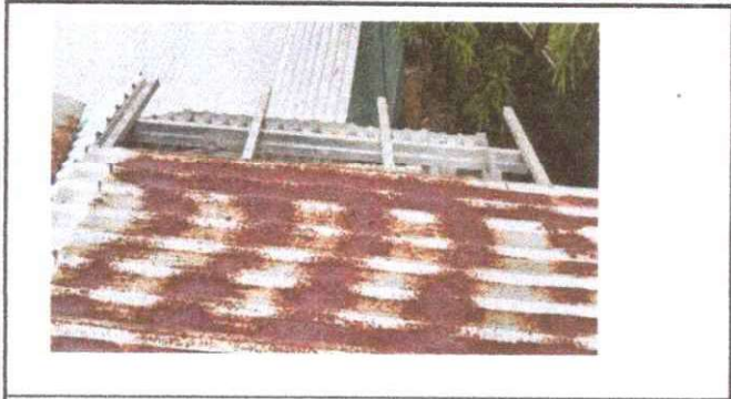
foto 1 sustitución de lamina
