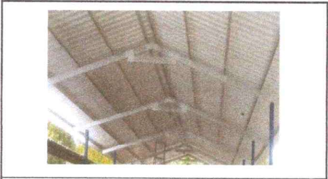
Foto 3 Sustitución de soporte de madera por metal
