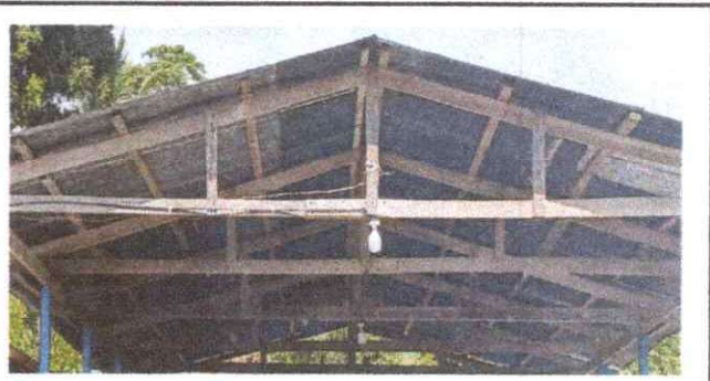
Foto 2 Sustitución de lamina
