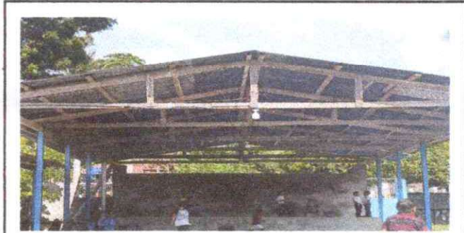
Foto 3 Sustitución de soporte de madera por metal
