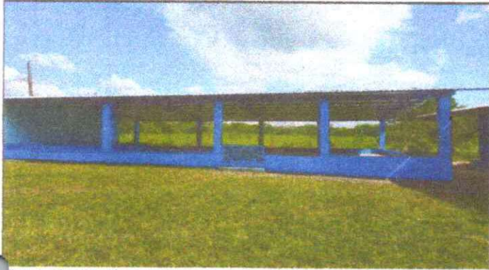
Foto 1: Sustrucción de estructura de soporte de madera por metal
