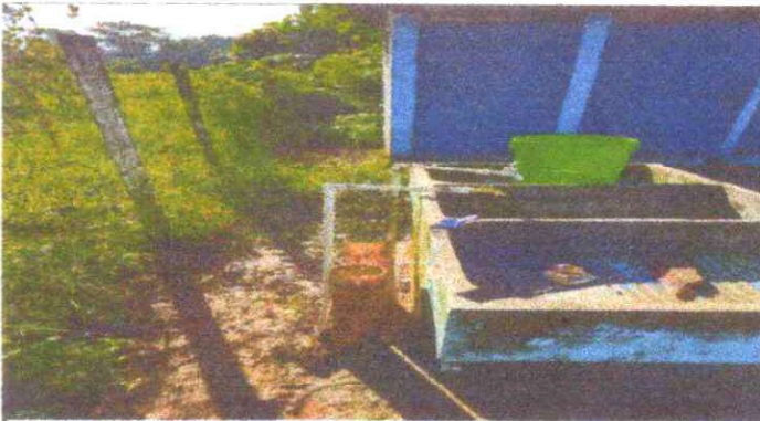
Foto 3: Sustrucción de tubería lineal principal
