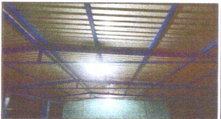
Foto 4: Reparación de cableado eléctrico.
