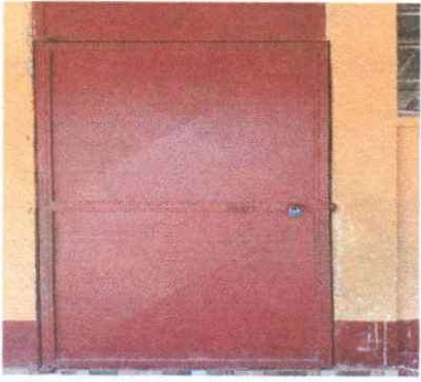
FOTO 3: SUSTITUCION DE PUERTAS
