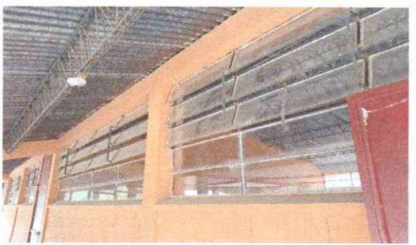
SUSTITUCION DE BALCONES
