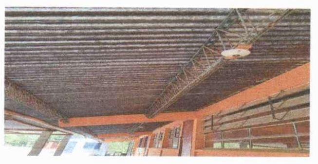
FOTO 2: SUSTITUCION DE ESTRUCTURA DE METAL POR METAL
