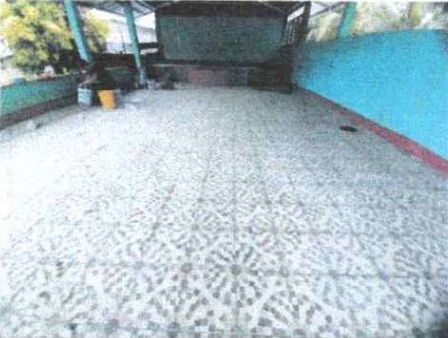
FOTO 3: SUSTITUCION DE PISO DE TORTA DE CONCRETO
