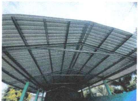
FOTO 4: INSTACION DE ESTRUCTURA PORTANTE DE METAL
