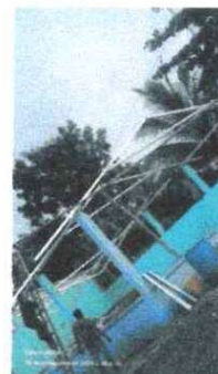
FOTO 4: INSTACION DE ESTRUCTURA PORTANTE DE METAL
