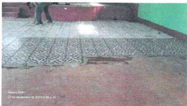
FOTO 3: SUSTITUCION DE PISO DE TORTA DE CONCRETO
