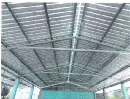
FOTO 5: INSTACION DE LAMINA TROQUELADA ALUZINC
