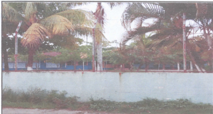
Reparación de muro perimetral de block
