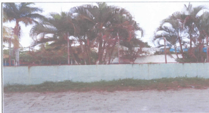
Reparación de muro perimetral de block
