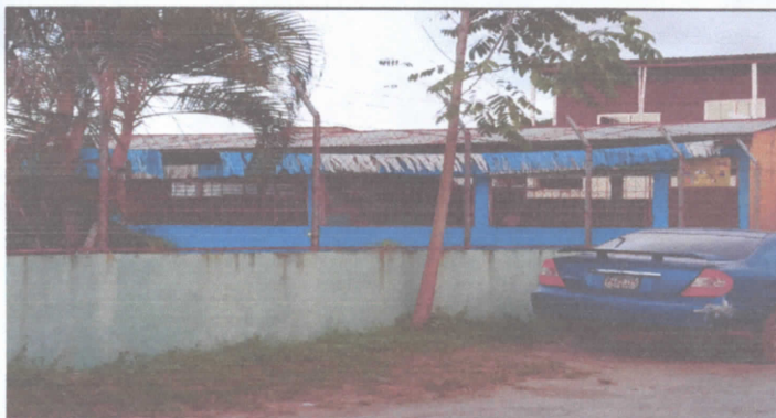
Reparación de muro perimetral de block
