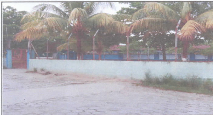
Reparación de muro perimetral de block
