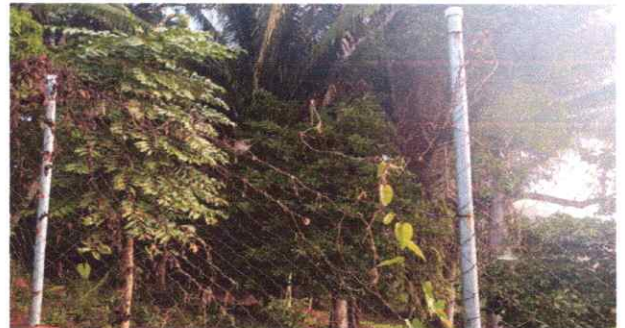
Foto 4 REPARACION DE MALLA GALVANIZADA
