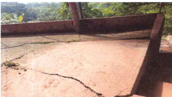
FOTO 5 SUSTITUCION DE TORTA DE CEMENTO
