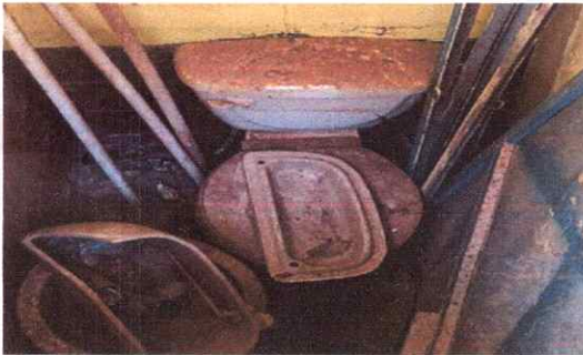
FOTO 3 SUSTITUCION DE INODORO
