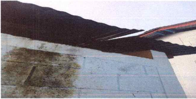
FOTO 1: SUSTITUCIÓN DE LÁMINA Y ESTRUCTURA DE MADERA A METALICA
