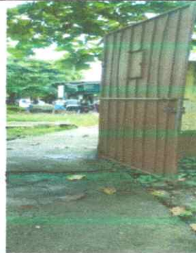
Foto 4: REMOZAMIENTO PORTÓN DE INGRESO
