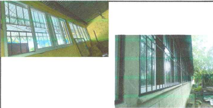
Foto 5: SUSTITUCIÓN VENTANAS DE MADERA POR PVC
