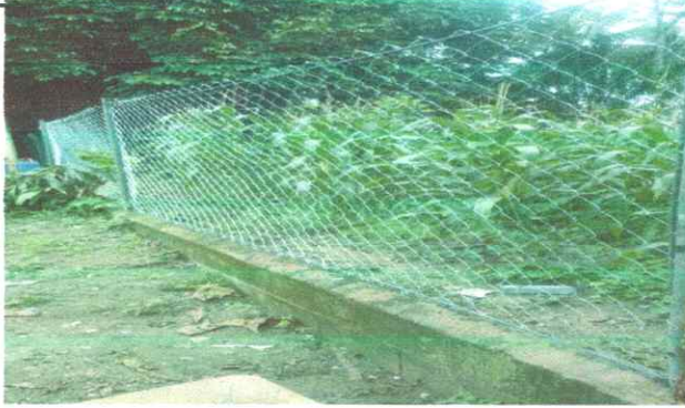
Foto 1: REMOZAMIENTO MURO PERIMETRAL
