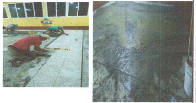
Foto 2: SUSTITUCIÓN PISO TORTA DE CONCRETO A AULAS Y PASILLO
