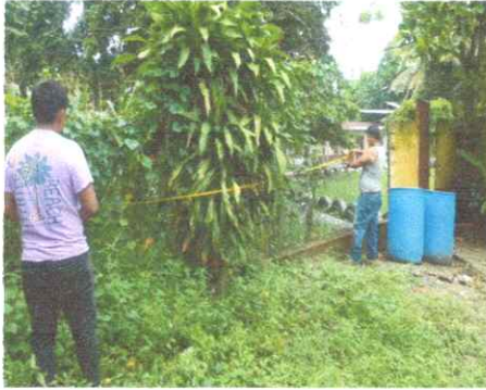
Foto 1: REMOZAMIENTO MURO PERIMETRAL
