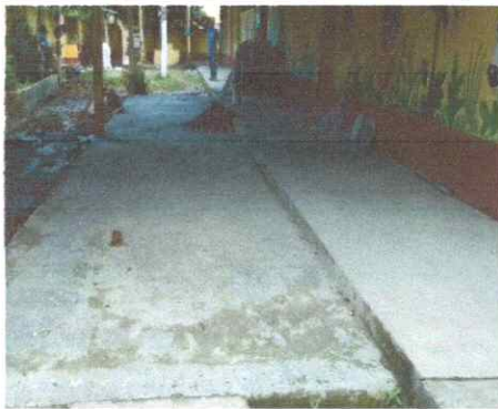
Foto 3: SUSTITUCIÓN PISO TORTA DE GALERA USOS MULTIPLES
