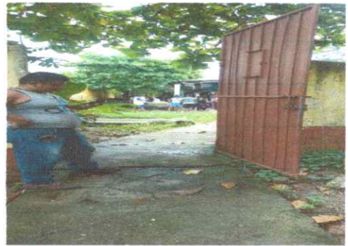
Foto 4: REMOZAMIENTO DE PORTON DE INGRESO
