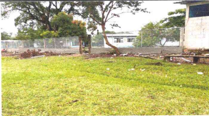
Foto 3: Reparación de muro perimetral
