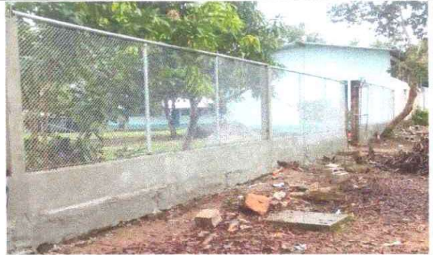
Foto 4: Mantenimiento a Muro perimetral del centro educativo.
