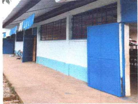
Foto 2: Mantenimiento a estructura de metal de ventana
