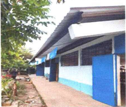
Foto 1: SUSTITUCIÓN DE LÁMINA, POR LAMINA TROQUELADA ALUZINC CALIBRE 26
