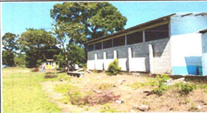
Foto 3: Reparación de muro perimetral
