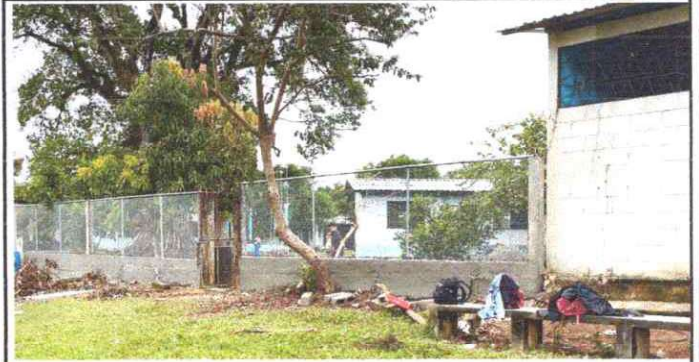
Foto 4: Mantenimiento a Muro perimetral del centro educativo.
