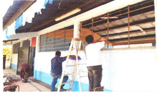
Foto 2: Mantenimiento a estructura de metal de ventana
