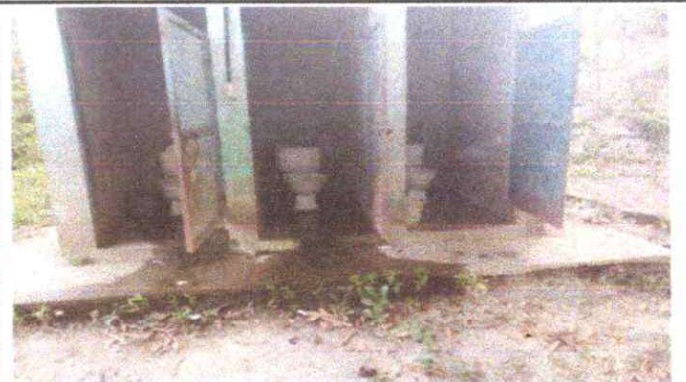
Foto 4: SUSTITUCIÓN DE INODORO
