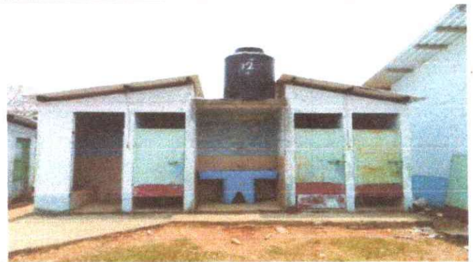
Foto 2: SUSTITUCIÓN DE PUERTAS
