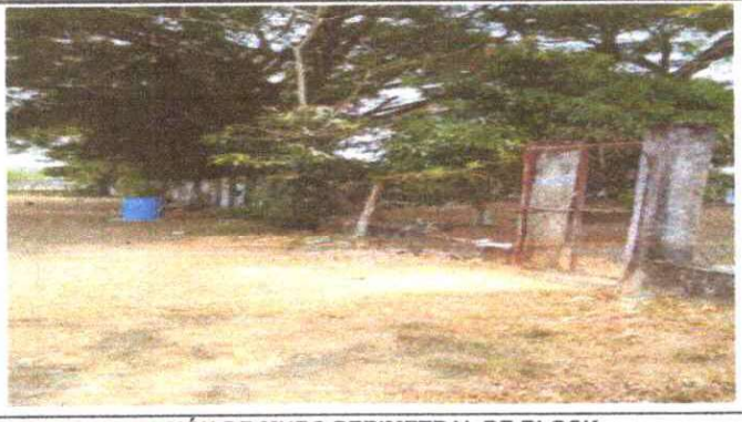
Foto 5: REPARACIÓN DE MURO PERIMETRAL DE BLOCK
