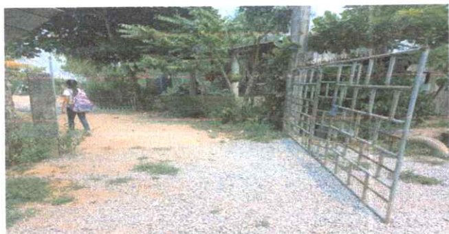
Foto 1: SUSTITUCION DE PORTON
