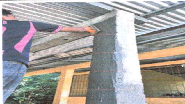
Foto 2: REMOZAMIENTO DE COLUMNAS
