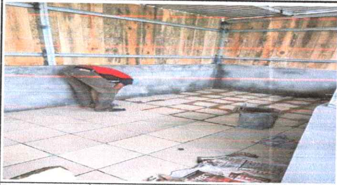
Foto 7: SUSTITUCIÓN DE PISO CERAMICO
