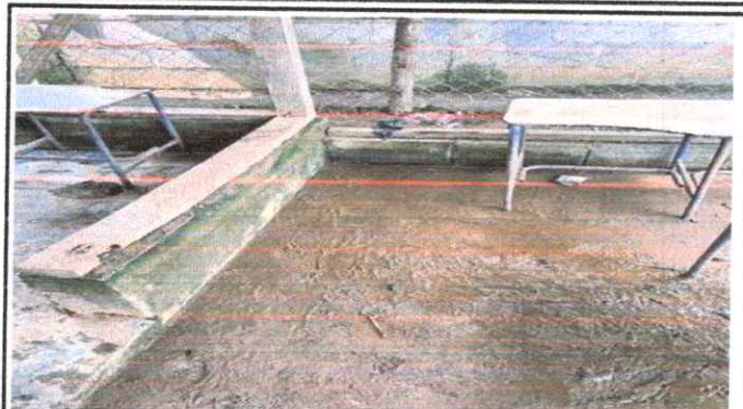
Foto 8: SUSTITUCION DE PISO DE TORTA DE CONCRETO
