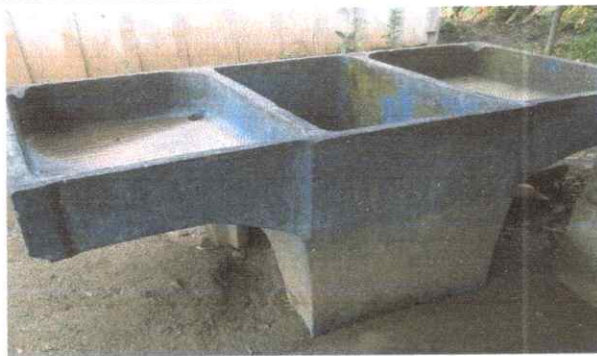
Foto 3: SUSTITUCION DE PLILA DE DOS LAVADEROS MAS INTALACIÓN DE AGUA POTABLE
