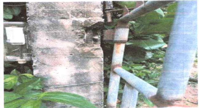
Foto 2: REMOZAMIENTO DE COLUMNAS
