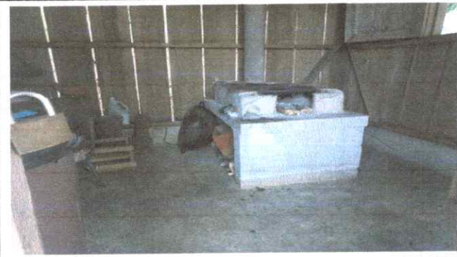
Foto 4: SUSTITUCION DE ESTUFA RURAL, CON CHIMENEA Y PLANCHA DE METAL
