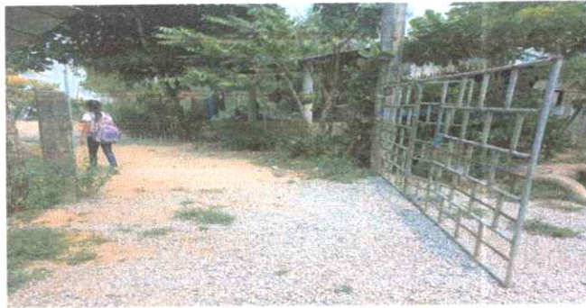
Foto 1: SUSTITUCION DE PORTON
