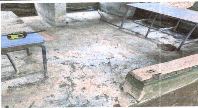
Foto 7: SUSTITUCIÓN DE PISO CERAMICO
