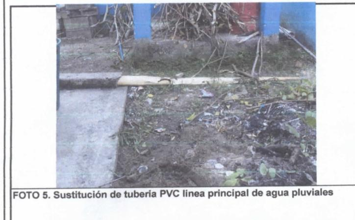
FOTO 5. Sustitución de tubería PVC línea principal de agua pluviales
