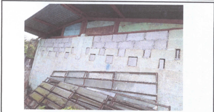
Foto No. 2 pared en mal estado parte trasera sin repello
