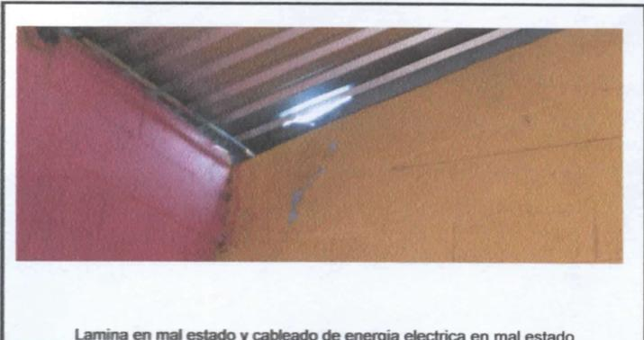
**Lamina en mal estado y cableado de energia electrica en mal estado**
