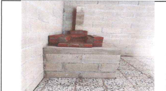
Foto 1: Sustitución de estufa rural completa incluyendo chimenea y plancha de metal
