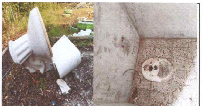
Foto 6: sustitucion de baños de inodoro
