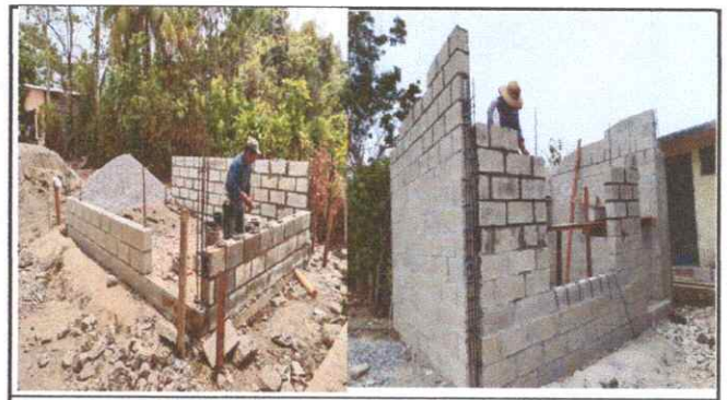
Foto 4: Demolicion de muras de concreto y continuacion de paredes de cocina
