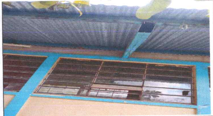
Mantenimiento de ventanas
