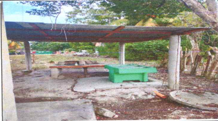
Sustitución de estufa rural (completa) incluye chimenea y plancha de metal
