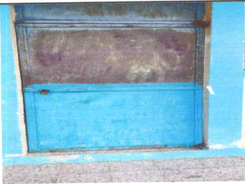
Sustitución de puerta
