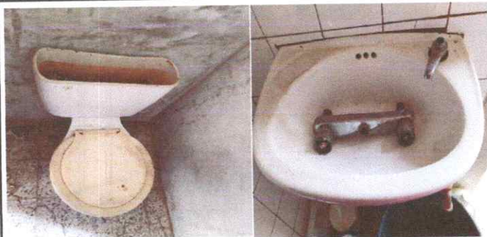
SUSTITUCION DE BAÑOS Y LAVAMANOS
