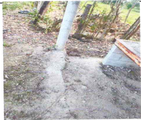
Seguimiento y continuación de paredes de la cocina de block
