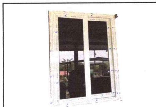
Foto 5: Sustitucion de ventana por ventana p.v.c
