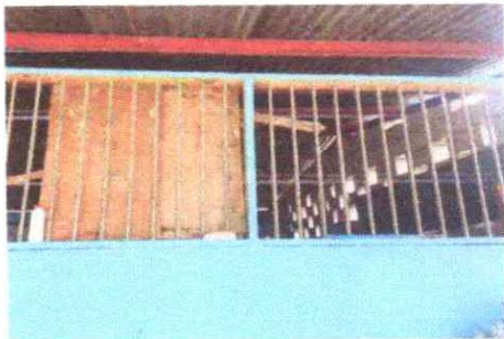
Foto 5: Sustitucion de ventana por ventana de pvc
