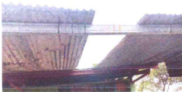
Foto 3: Mantenimiento de Estructura Metalica
