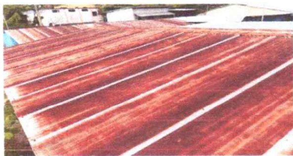
Foto1: Mantenimiento de techo
