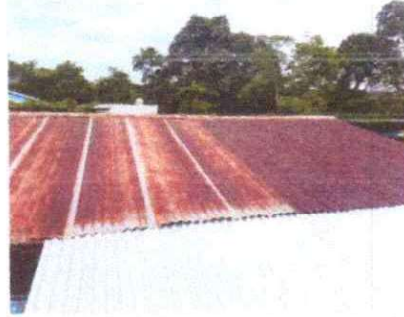
Foto 2: Mantenimiento de techo
