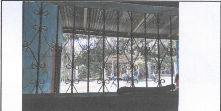
SUSTITUCION DE VENTANAS DE MADERA POR METAL
