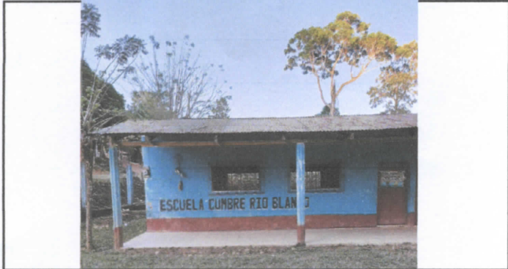
SUSTITUCION DE LAMINA POR LAMINA TROQUELADA CALIBRE 26
