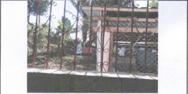
SUSTITUCION DE VENTANAS DE MADERA POR METAL
