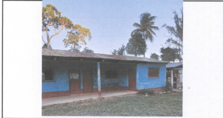
SUSTITUCION DE LAMINA POR LAMINA TROQUELADA CALIBRE 26
