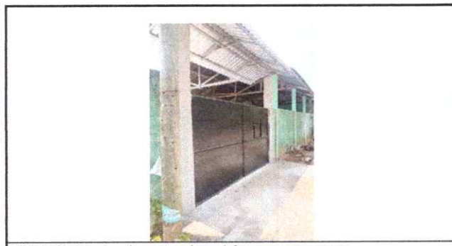
Foto 5: Sustitución de porton de metal
