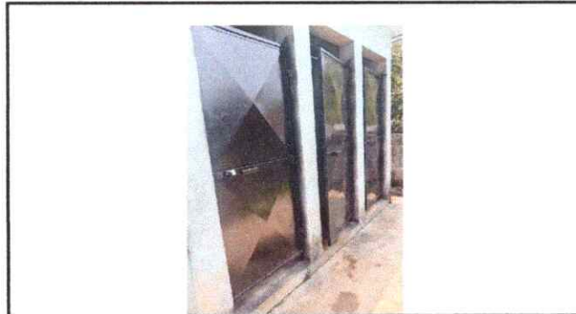
Foto 4: Sustitución de puertas en servicios sanitarios
