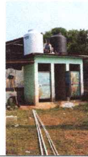
Foto 8: Sustitucion de deposito de agua 1100 Lts
