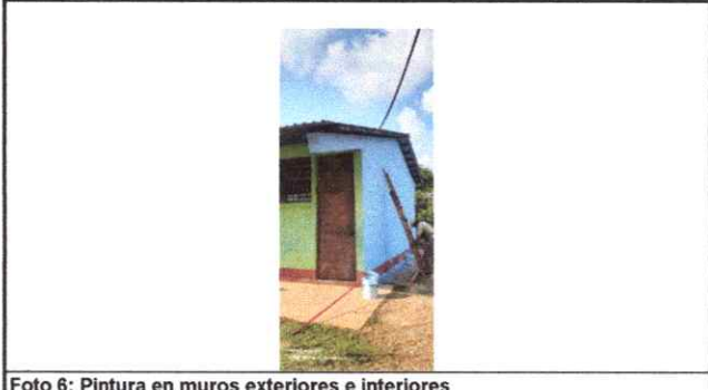
Foto 6: Pintura en muros exteriores e interiores
