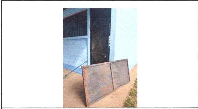
Foto 3: Sustitución de puertas
