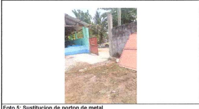
Foto 5: Sustitución de porton de metal
