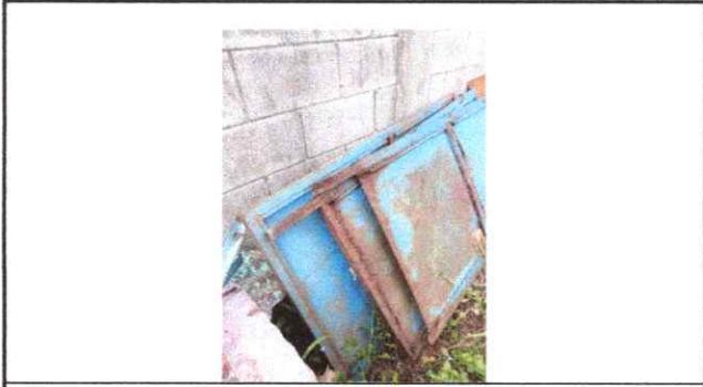
Foto 4: Sustitución de puertas en servicios sanitarios
