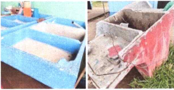
Foto 9: Sustitucion de pila de cemento de dos lavadores
