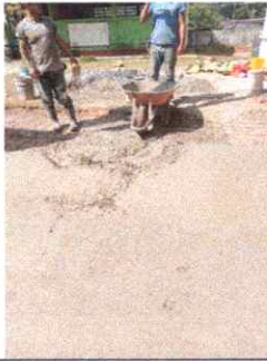
Foto 7: Reparacion de planchas de concreto de patio
